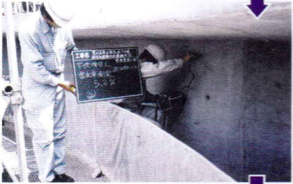
防食被覆塗装前 含水率測定状況
