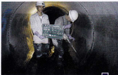
Vカット後 注入口・ドリルφ15mm 穴開作業状況
