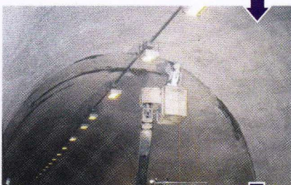
コンクリート打ち継部 導水作業状況
