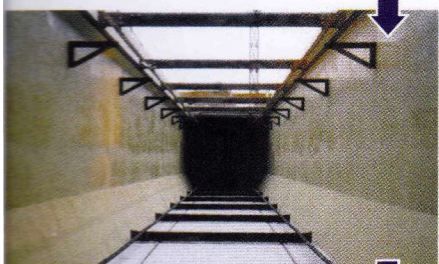
施工後 上流側
