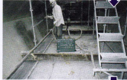
防食被覆塗装作業状況 (タフガードRG) C種 2mm以上
