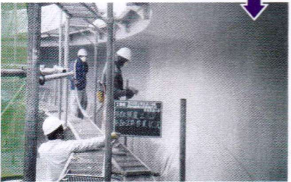
防食被覆塗装作業状況 (タフガード RG) C種 2mm以上
