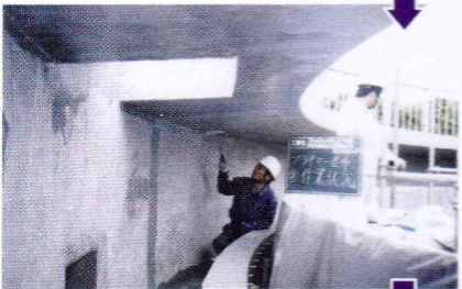
プライマー塗布作業状況
