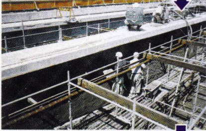
下地修復作業状況 (無収縮モルタル 2~3cm)
