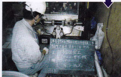
防食被覆塗装 機械操作状況
