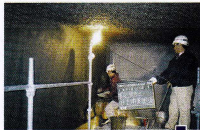
下地修復作業状況 塗り厚さ 2cm
