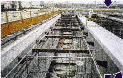
下地修復後養生期間
