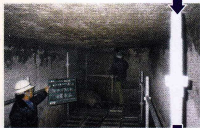
研り作業状況 (ウォーターブラスト) 最高圧力: 1500kg/cm 2 吐出量: 52ℓ/min 劣化部厚さ 2cm
