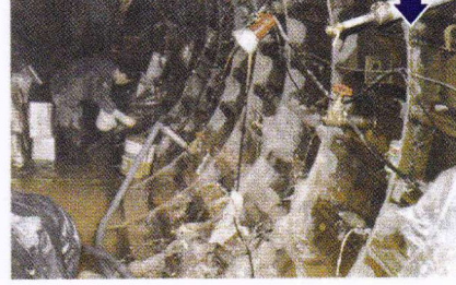
止水工事作業状況
