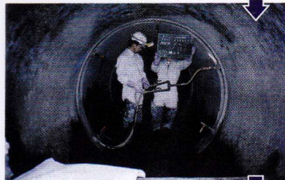
セメント注入作業状況
