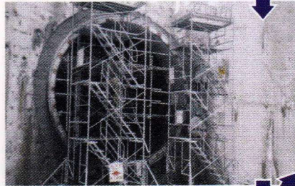
坑口の止水工事作業状況
