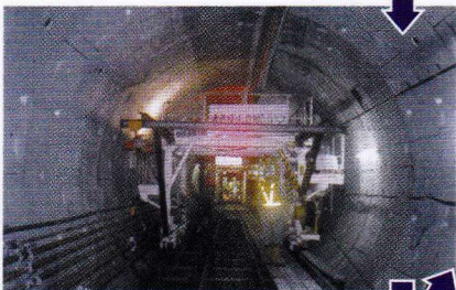
作業台車に乗っての 作業状況
