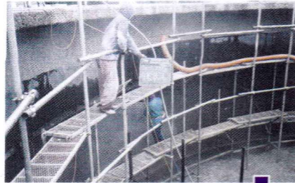
研り作業状況 (ウォーターブラスト) 最高圧力：1500kg/cm 2 吐出量：52ℓ/min 劣化部厚さ 3cm
