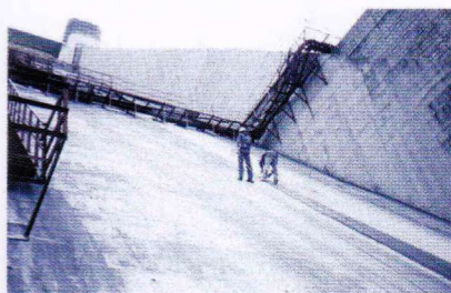
命綱1本で放流面の 止水工作業状況
