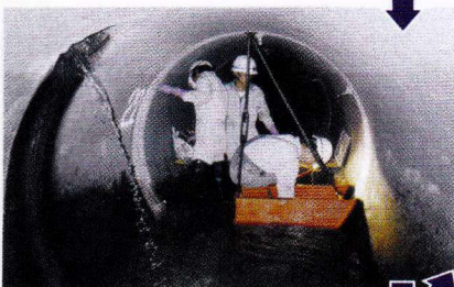
コーキング、パイプセット 作業状況
