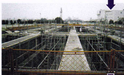
足場組立状況
