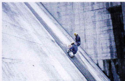
コンクリート打ち継部 止水工事
