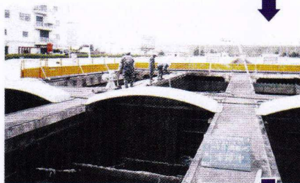
清掃作業状況 (高圧洗浄車4t使用)
