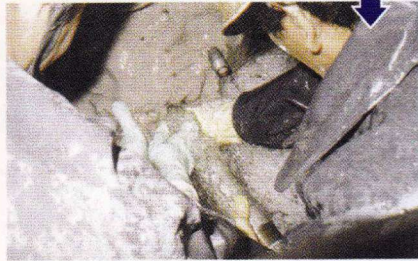
止水工事作業状況
