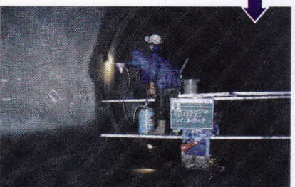
ジョイント部 止水剤注入 (ウレタン) 作業状況
