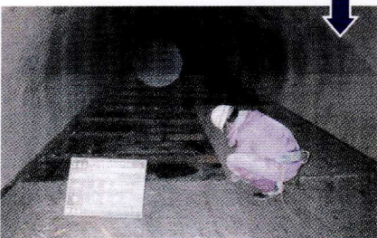
足場解体作業状況
