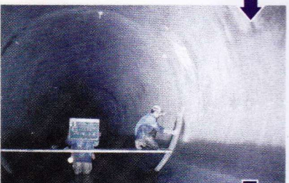
ジョイント部 コーキング・パイプセット 作業状況
