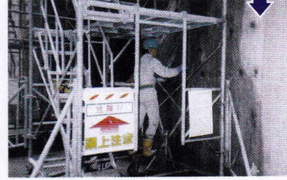
仕上作業状況
