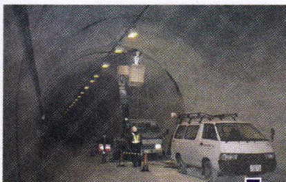
作業状況 (高所作業車使用)
