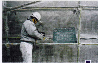
防食被覆塗装前 含水率測定状況
