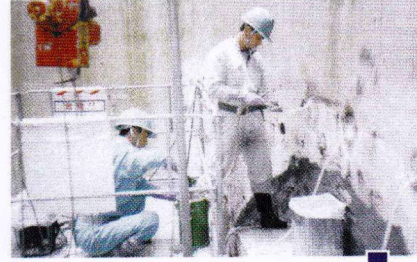
止水剤注入 (ウレタン) 作業状況
