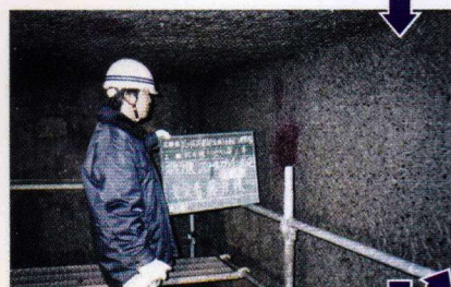
研り後 フェノールフタレイン溶液 にて反応検査 研り厚さ 2cm
