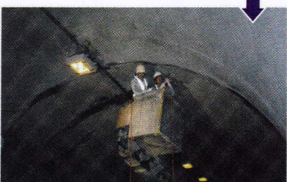
クラック部 導水作業状況
