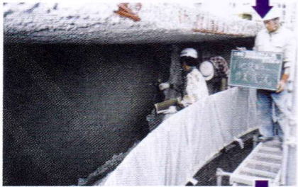
下地修復作業状況 塗り厚さ 3cm
