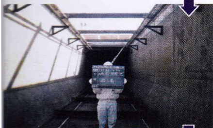
施工前 上流側
