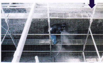
劣化部研り作業状況 (ウォーターブラスト) 最高圧力：1500kg/cm 2 吐出量：52ℓ/min 劣化部厚さ 2~3cm
